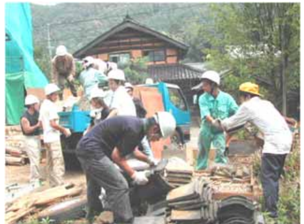
解体に、多くのボランティアが参加しました
